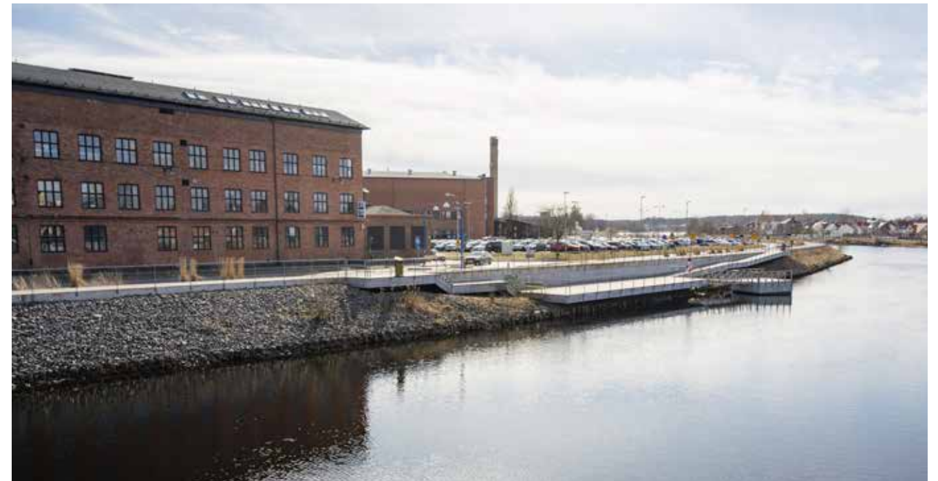
Efter att Karlstad drabbats av höga älvvattennivåer i början av 2000-talet bestämde sig Karlstad kommun och Region Värmland för att tillsammans säkra centralsjukhuset. Invallningen fungerar också som gång- och cykelbana utmed älven och runt halva sjukhusområdet. Foto: Fredrik Karlsson
