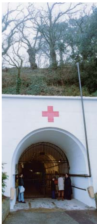
Sjukhuset ligger djupt nergrävt i bergssidan.
