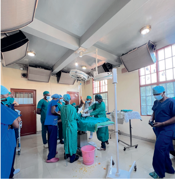
Figur 2. Installation av tilluftsaggregat och 6 väggmonterade luftrenare i en enkel operationssal. CELPA-sjukhuset i Demokratiska republiken Kongo (test 5).
